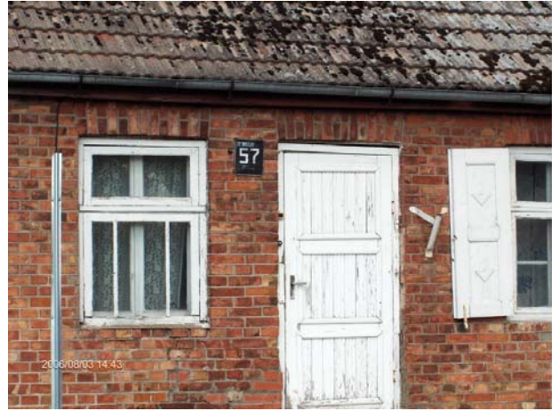
Dzīvojamā ēka (bijusī dzelzceļa stacijas ēka), Dzintaru iela 57
